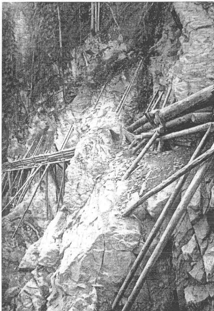
Reistkanal im Unterengadin. Damit wurde das Brennholz von den Abhängen hinunter in den Inn gebracht, von wo es häufig in die Salzpannen gelangte. (Bild: Forstinspektorat Graubünden, gedruckt in: BAVIER J.B., Schöner Wald in treuer Hand. Ein Buch über den Schweizerwald herausgegeben vom Schweizerischen Forstverein. Aarau 1949, S. 60.)
